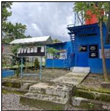
Gambar 1 Fasilitas Sentral Pengelolaan PAMSIMAS Dusun Karanglo (Kantor Operasional dan Menara Reservoir)
