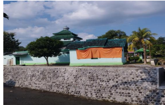
Gambar 1.7 Perbaikan di Kali Celeng
